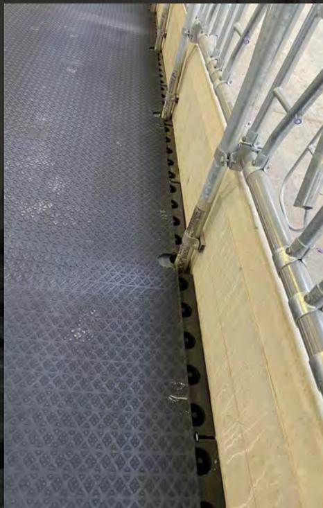
Podest aus modularen **Kunststoffblöcken** für eine schnelle Montage
